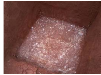
Figura 14 – Camada de solo-RCD compactada
