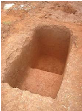
Figura 12 – Vala escavada para realização dos ensaios (parte mais profunda destinada à camada compactada de solo-RCD)
