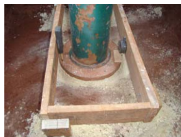
Figura 17 – Placa e extensômetros instalados
