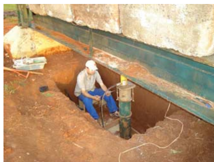
Figura 18 – Execução do ensaio de placa
