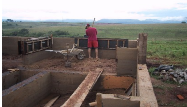
Foto 2. Construção de habitação residencial com paredes monolíticas de solo-cimento (Cohab Santa Marta, Santa Maria)
