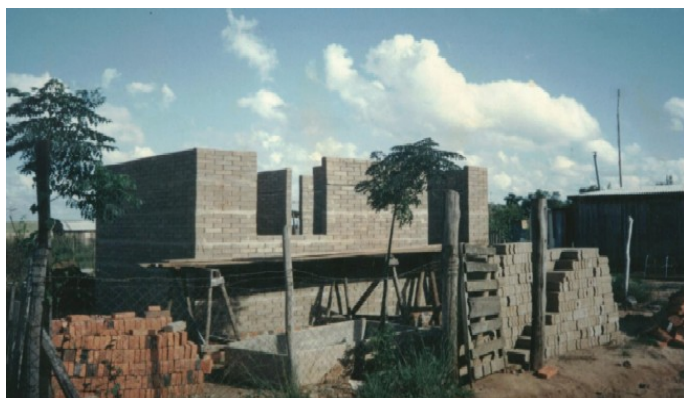
Foto 1. Construção de habitação residencial com uso de tijolos de solo-cimento.
