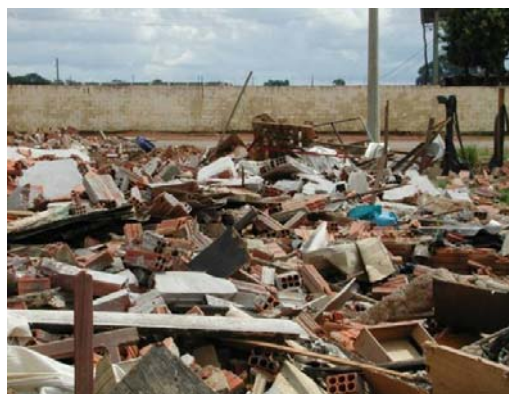
Figura 1 - Resíduos da construção e demolição
