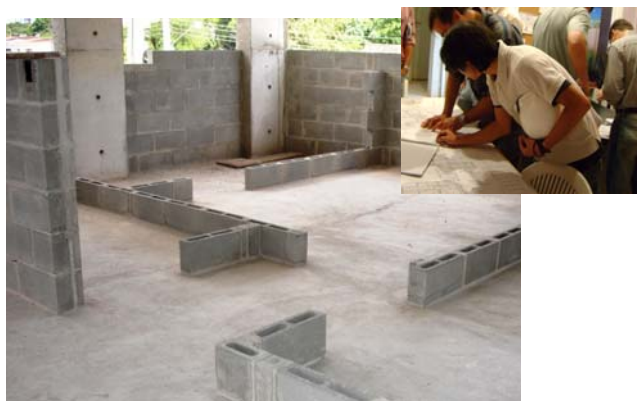
Figura 2 – Alvenaria de vedação racionalizada: organização, projeto para produção, produtividade
