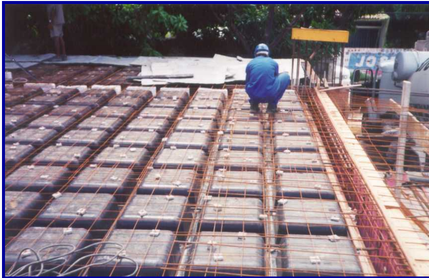
Figura 2 – Montagem de uma laje nervura com cubas plásticas
