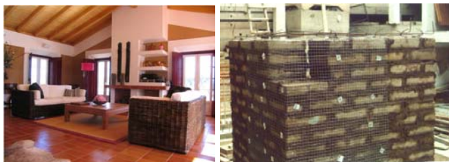
Figura 5 - À esquerda, habitação para turismo rural [Naturarte, 2007] na localidade de Vila Nova de Mil Fontes, com uma viga de bordadura em betão armado e, à direita, malha electrossoldada cravada numa parede de adobe, onde já existe o espaçamento para colocar o dente em betão armado, que irá ficar ligado à viga de bordadura [16]
