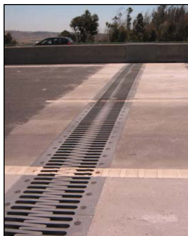
Figura 10 - Pente metálico com dentes rectangulares (à esquerda) e triangulares (à direita) [5]
