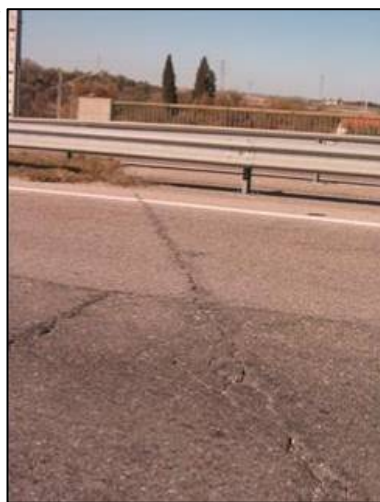
Figura 3 - Junta oculta: pormenorização de projecto (à esquerda) [6]; exemplo real já degradado (à direita) [5]
