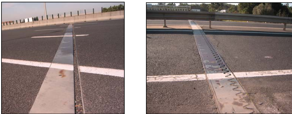
Figura 8 - Juntas de chapas deslizantes sem dentes (à esquerda) e com dentes (à direita) [5]
