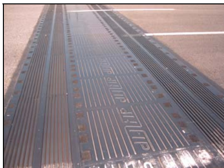
Figura 11 - Junta de elastômero armado composta RAN P da FIP Industriale (à esquerda) [5] e Esquema de junta Éole (à direita) (adaptada de [10])
