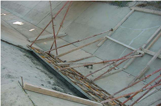
Fig. 3 - Sistema de cofragem tradicional de espaldas
