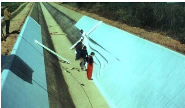
Fig. 10 - Vista de um canal com membranas de PVC
