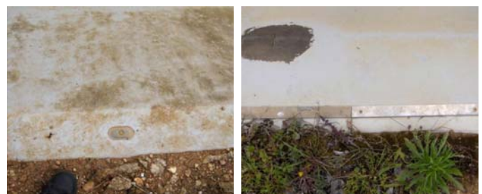
Fig. 11 - Fixação mecânica pontual (à esquerda) e contínua (à direita) na pestana de um canal
