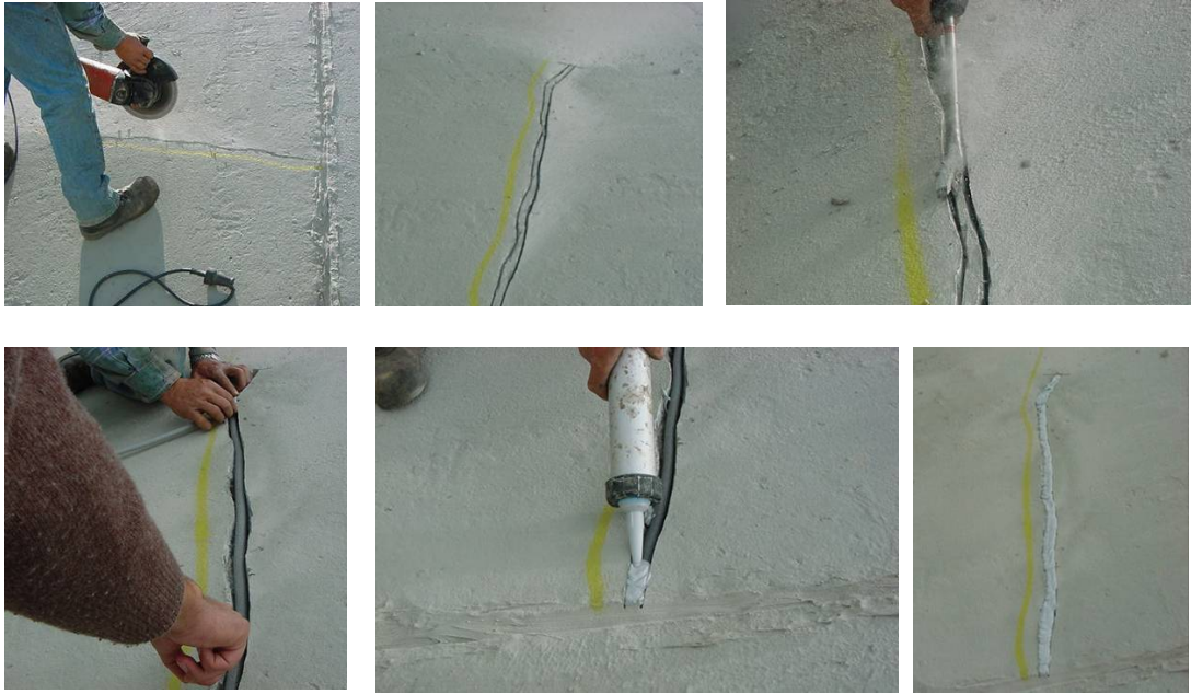
Fig. 14 - Sequência de reparação de uma fissura no revestimento de betão
