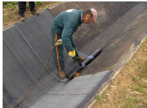
Fig. 6 - Aplicação de membrana betuminosa com a chama de um maçarico sobre um primário betuminoso
