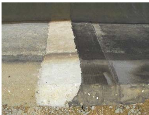
Fig. 8 - Ancoragem transversal com argamassa de uma membrana betuminosa
