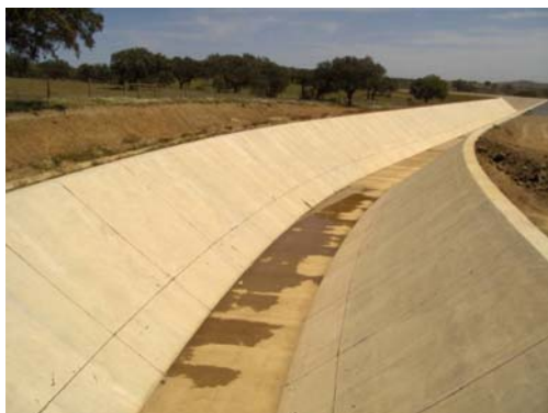
Fig. 1 - Canal de betão com juntas transversais e longitudinais
