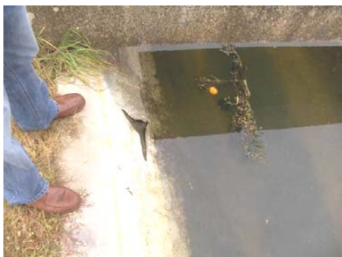
Fig. 13 - Membrana de PVC rasgada
