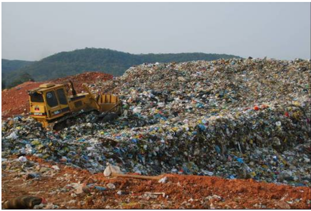
Figura 5 – Compactação de resíduos em rampa
