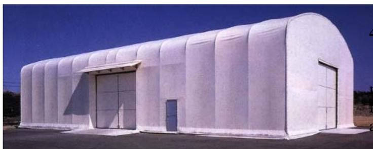
Figura 5 - Armazém semi-rígido revestido com uma película de  $\text{TiO}_2$  [3]
