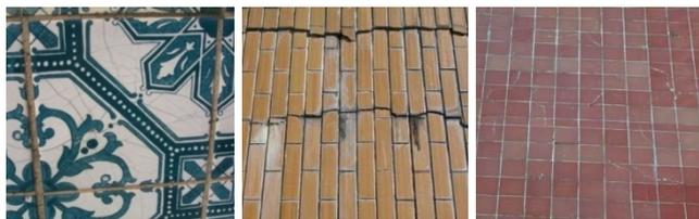
Fig. 1 - Exemplos dos diferentes tipos de fendilhação: do vidroado, com direcção marcada e sem direcção preponderante (da esquerda para a direita)
