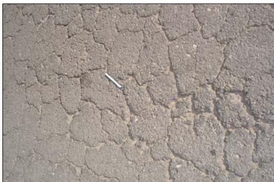
Figura 1 – Trincamento por fadiga
