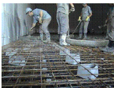
Obra recebe espaçadores e aparadores de concreto
