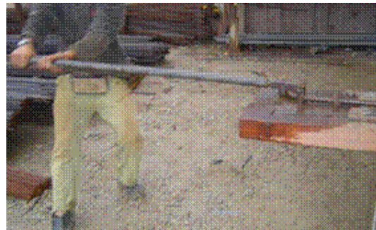
Dobramento de vergalhão
