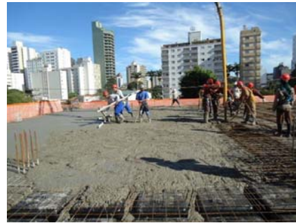
Armação e concretagem de laje nervurada bidirecional
