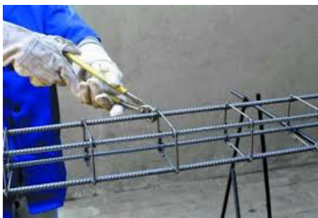
Montagem da armação
