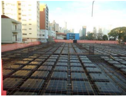
Armação e concretagem de laje nervurada bidirecional
