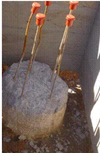
Estaca dentro da forma do bloco
