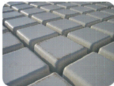
Formas montadas sobre o tabuleiro
