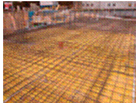
Armação de laje
