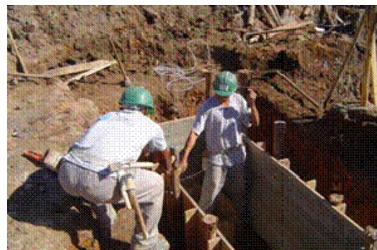
Colocação da forma
