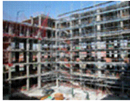
Estrutura de edifício (pórtico espacial)
