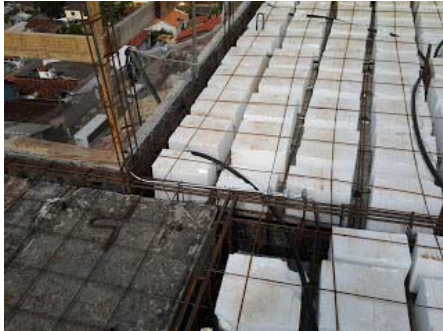
Laje nervurada com blocos de isopor
