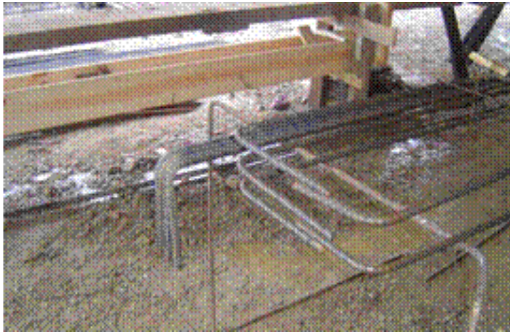
Mesa de armação – detalhe dos ganchos
