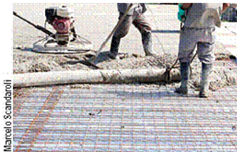
Concretagem de laje maciça
