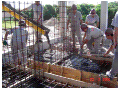
Concretagem: lançamento e vibração do concreto
