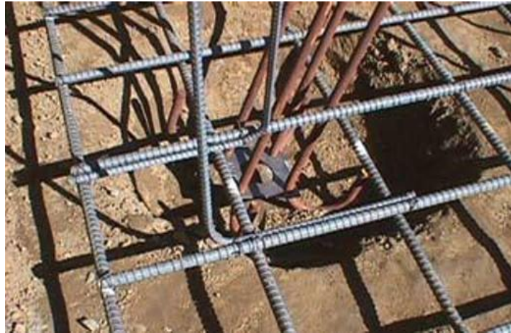
Apoio do pé da armadura de montagem na armadura inferior do bloco
