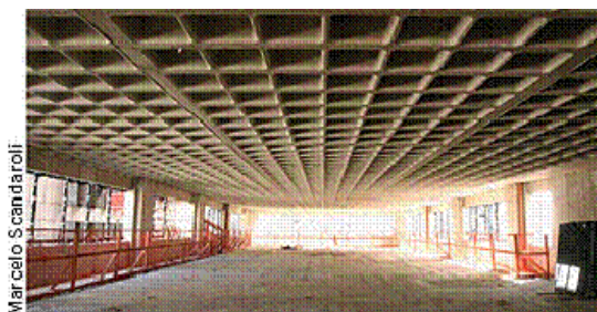
Vista inferior da laje nervurada (nervuras aparentes)
