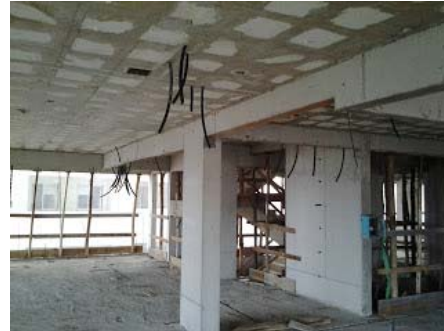
Laje nervurada com blocos de isopor
